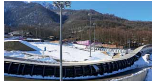
Санно-бобслейная трасса в Сочи. В данном проекте использовались натуральные материалы, клееный деревянный брус, местный натуральный камень.
